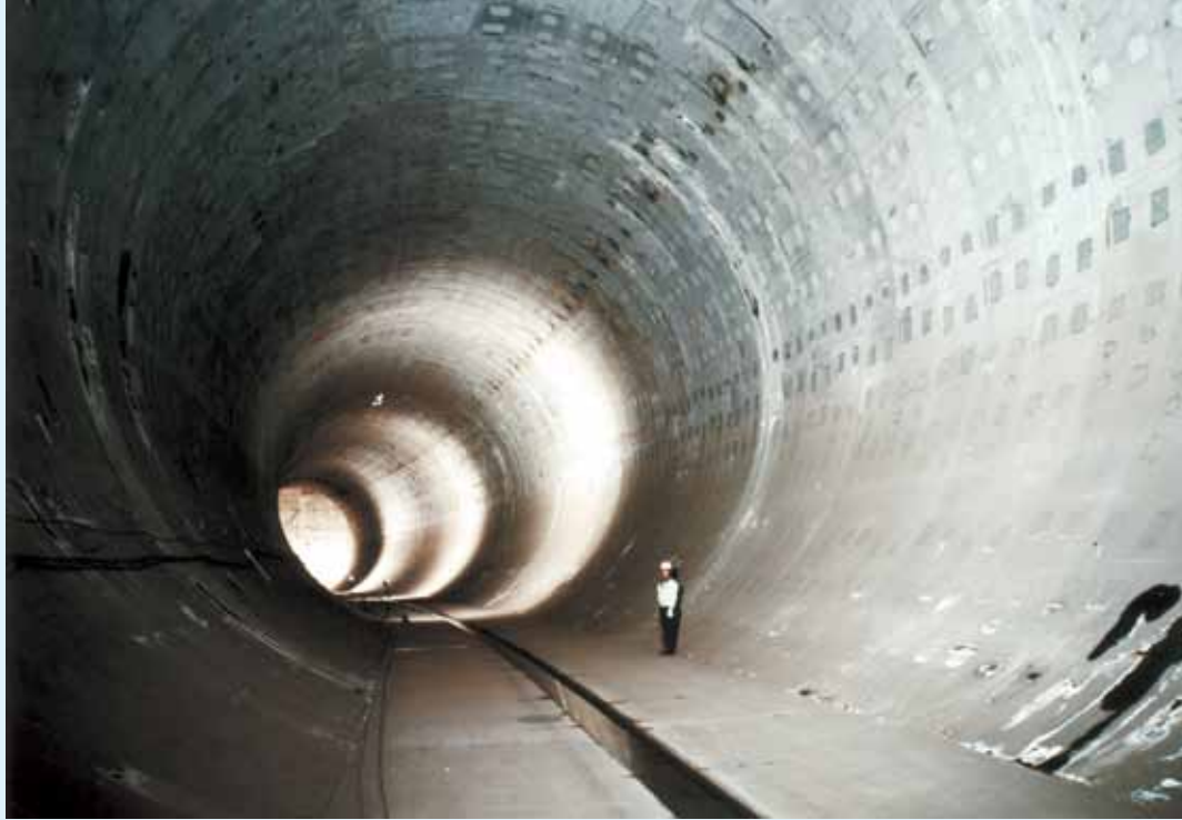
منظر داخلي لخزان المياه المندفعة. يمكن للخزان أن يستوعب ٥٤٠ ألف طن من مياه الفيضان.
