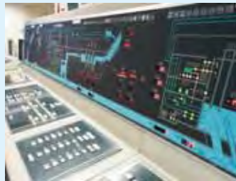
لوحة التحكم المركزية في مبنى زنبوكجي للتموين المائي بمحافظة طوكيو. يتم هنا فحص المياه المسحوبة من ثلاثة أنهار والتحكم في جميع العمليات من هذا المكان.
