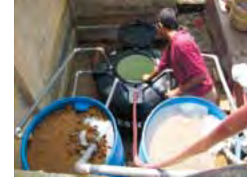
في الأسفل: يتمتع المجتمع المحلي هنا بمياه نظيفة وما عليهم إلا أن يضعوا مادة في المياه تجعل الشوائب المعلقة تتكتل معًا وتهبط في القاع.
