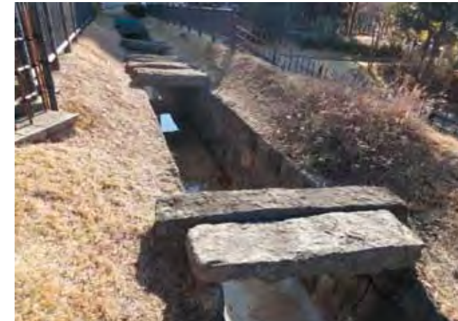
بقايا صهرج من مدينة إيدو القديمة، يوضع حوالي ثلثي الصهرج أسفل الأرض وتمر المياه عبر أنابيب لتستقر في النهاية في صهاريج جاهزة للاستعمال.
